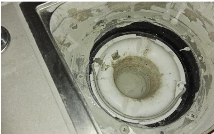
Membran, tettesjikt og overgang til sluk. - [Sluk utenfor dusjsonen.]
