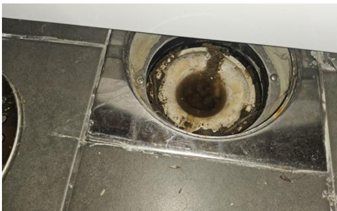
Avløpsrør. (Sjekkpunkter utover det som er inkludert i andre rom) - [Sluk under varmtvannsbereder.]
