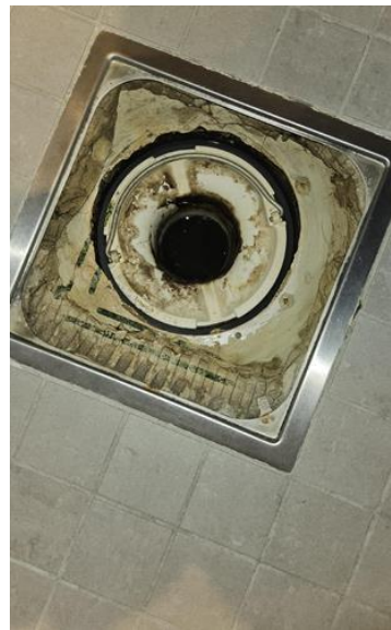
Membran, tettesjikt og overgang til sluk. - [Sluk i dusjsonen.]
