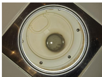
Tettesjiktets tilslutning til sluk - Sluk, bad.
