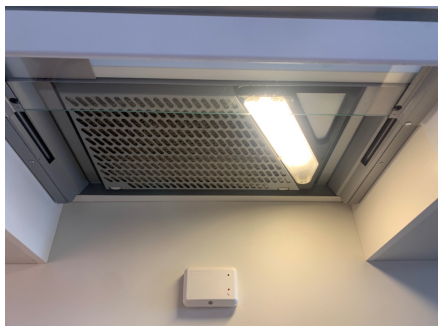
Spjellventilator over kokesone. Veggmontert komfyrvakt
