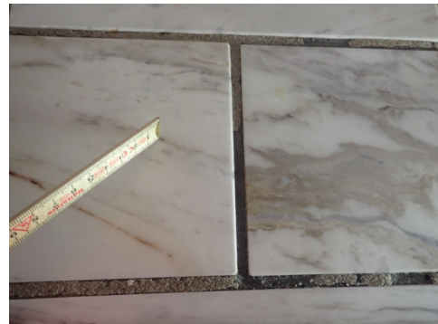
Flere fliser har løsnet fra underlaget.
