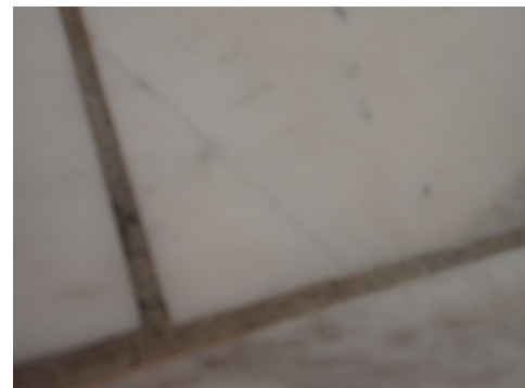
Flere fliser har løsnet fra underlaget.
