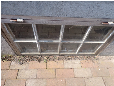
Værslitt vindu til intern krypkjeller.
