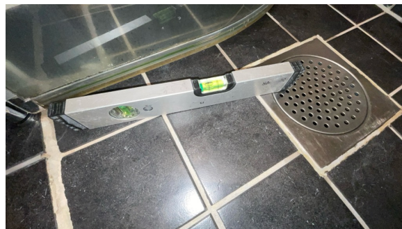
Fallforhold målt i retning sluk.
