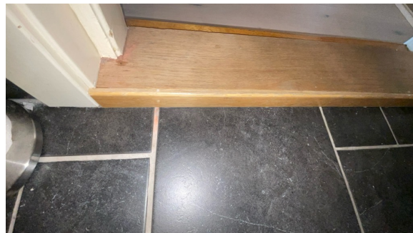
Overgang ved dørterskel.
