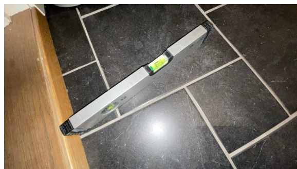
Fallforhold målt i retning sluk.
