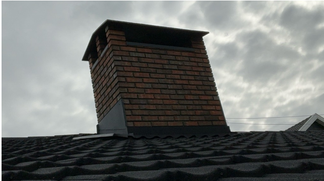
Skorstein over tak.
