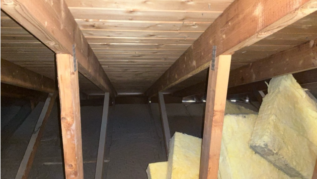
Synlig lufting gesimser.
