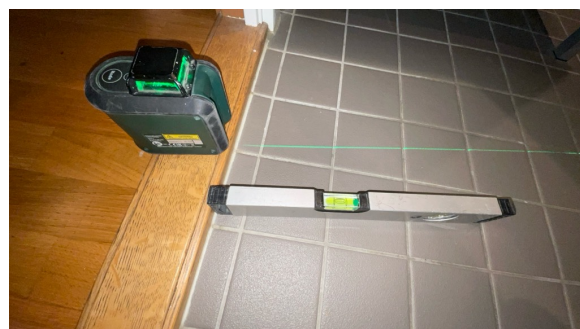
Fallforhold målt i retning sluk.
