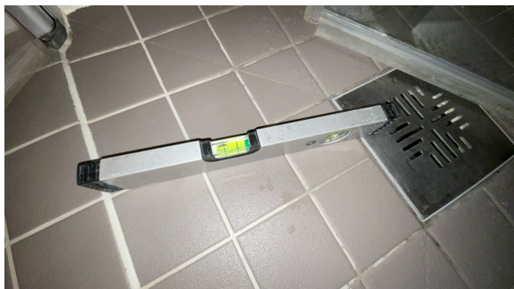
Fallforhold målt i retning sluk.
