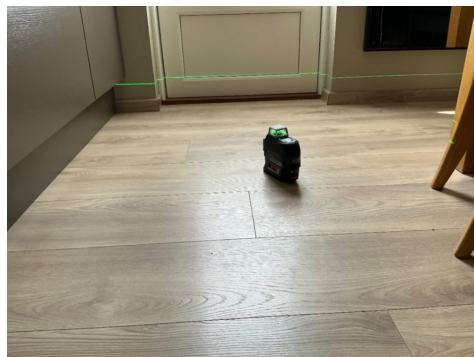
Fra balkonger og ut registrert 12mm på 2m
