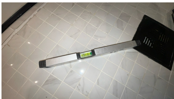
Fallforhold målt i retning sluk.
