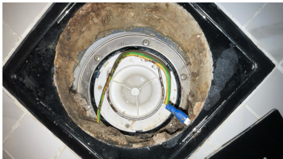
Synlig dukmembran under klemring i sluk.
