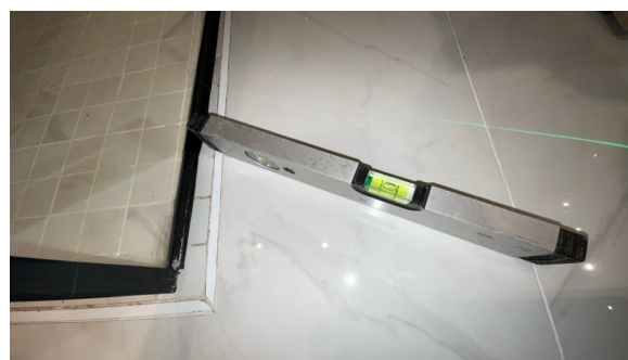
Fallforhold målt i retning sluk.
