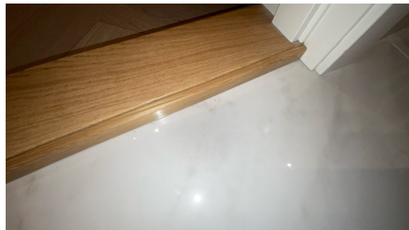
Overgang ved dørterskel.
