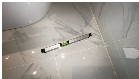
Fallforhold målt i retning sluk.
