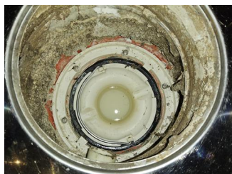
Tettesjiktets tilslutning til sluk - Sluk bad
