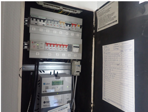
Usikrede ledninger på bad/vaskerom
