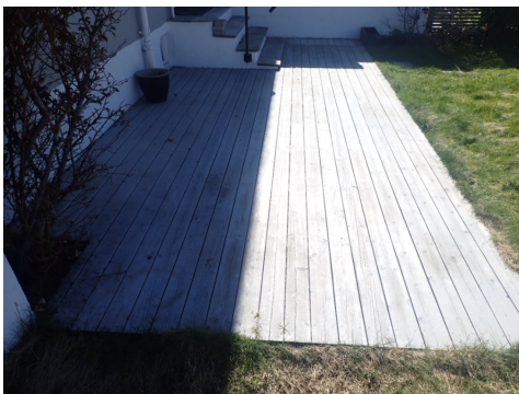
Treplattung til terrasse ligger delvis ned i terrenget
