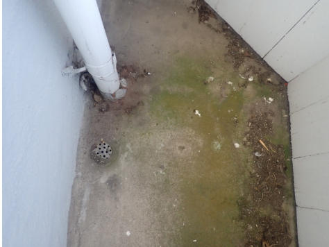
Avløp fra gulv via avløp i gulv
