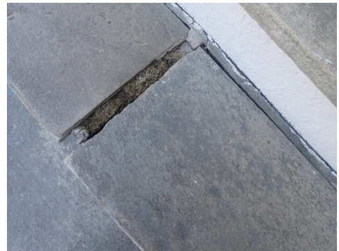
Skiferheller har løsnet
