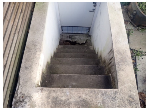
Støpt trapp til kjeller inngang utenfra
