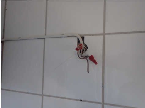
Usikrede ledninger på bad/vaskerom
