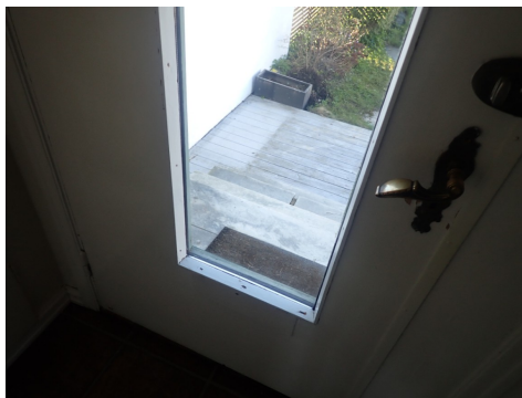
Det er sannsynlig skiftet glass i hoveddør etter byggeår.
