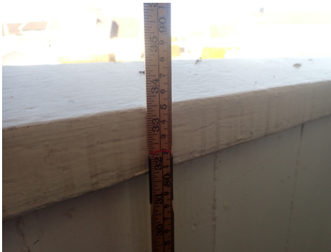
Rekkverk er 86 cm høyde
