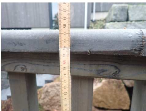
Rekkverk har høyde 85 cm.
