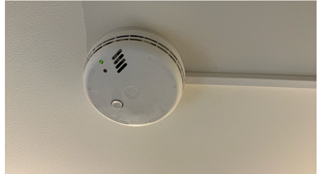
Brannvarsler. Tilkoblet strømmettet
