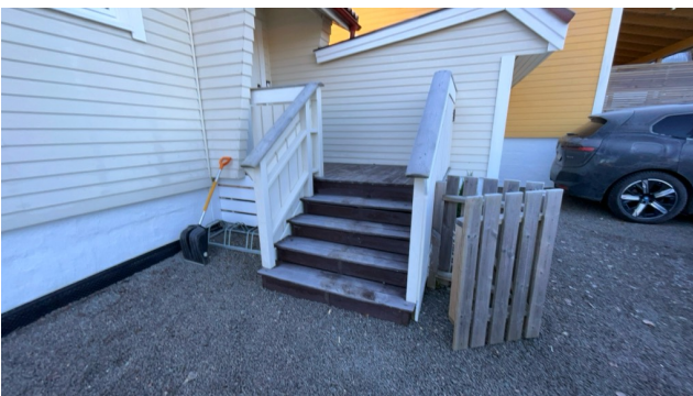
Besiktigelse av trapp.
