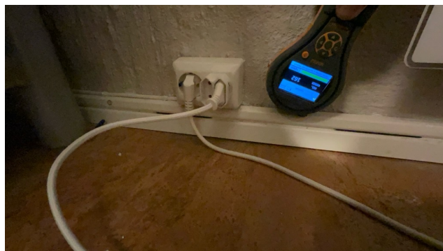
Utført fuktsøk på nedre del av grunnmur. Ingen høye fuktverdier ble påvist på befaringsdagen.
