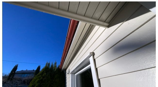
Synlige luftespalter i gesimskasse.
