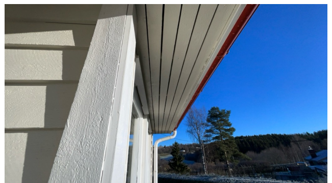
Synlige luftespalter i gesimskasse.
