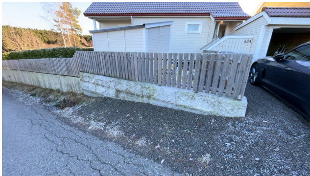
Besiktigelse av støttemur.
