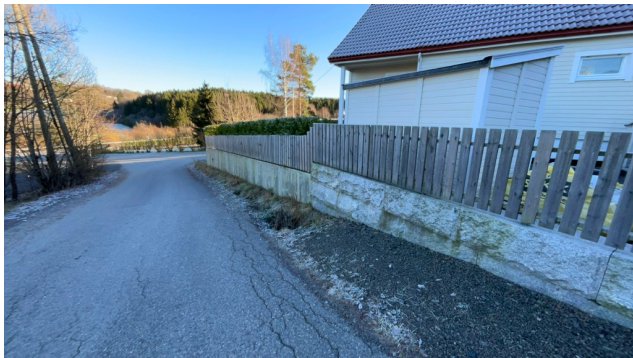
Besiktigelse av støttemur.
