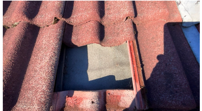
Kontroll av undertak.
