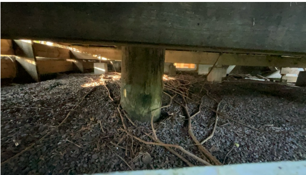
Kontroll av fundament.
