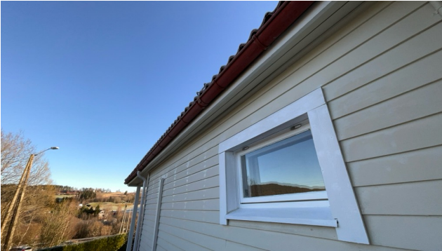
Synlige luftespalter i gesimskasse.
