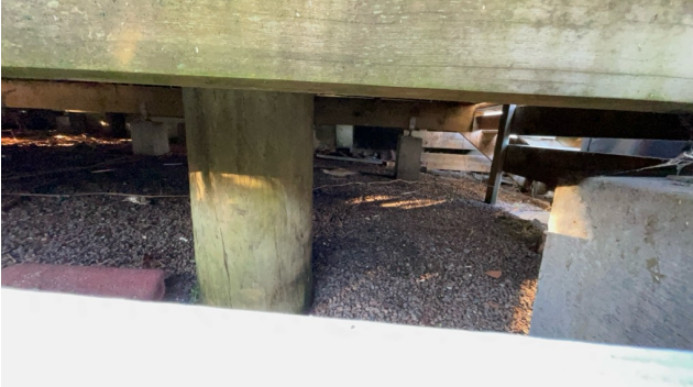
Kontroll av fundament.
