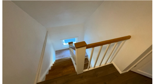
Besiktigelse av trapp.
