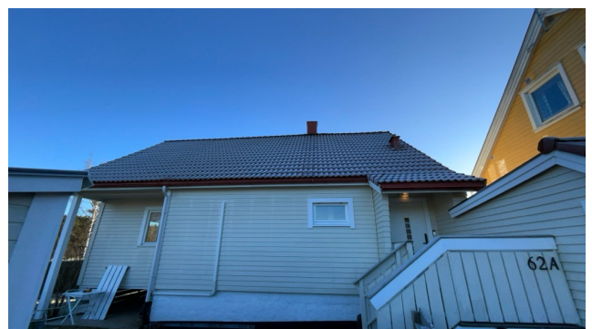
Besiktigelse av taktekke.
