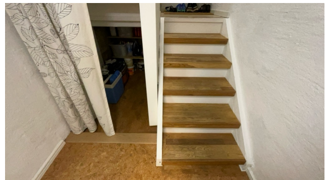
Besiktigelse av trapp.
