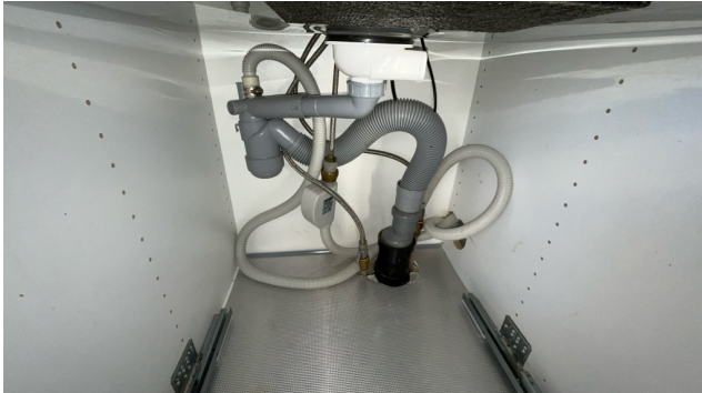
Besiktigelse av røropplegg.
