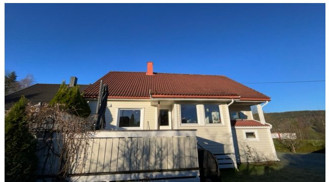
Besiktigelse av taktekke.
