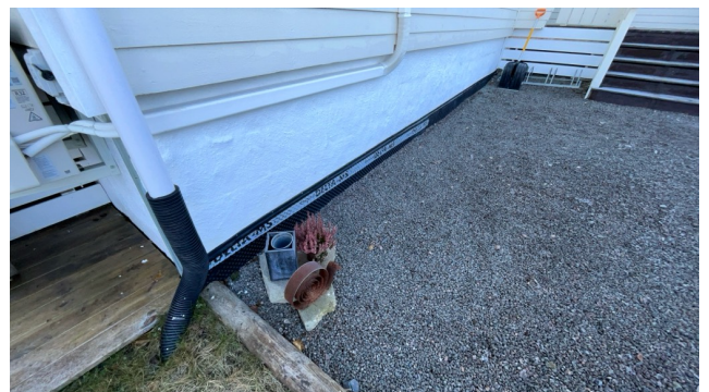
Kontroll av drenering/fuktsikring.
