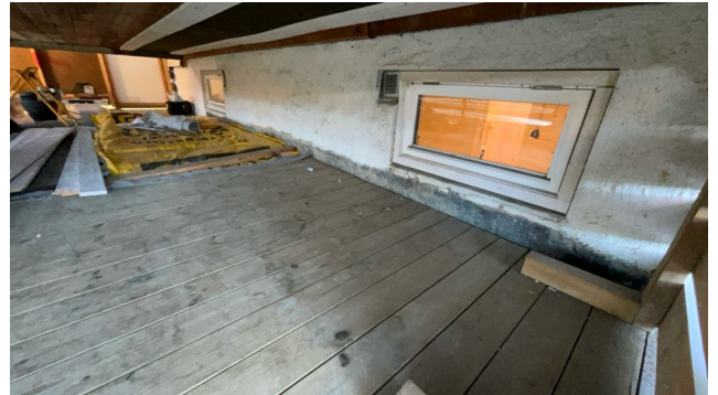
Kontroll av drenering/fuktsikring.
