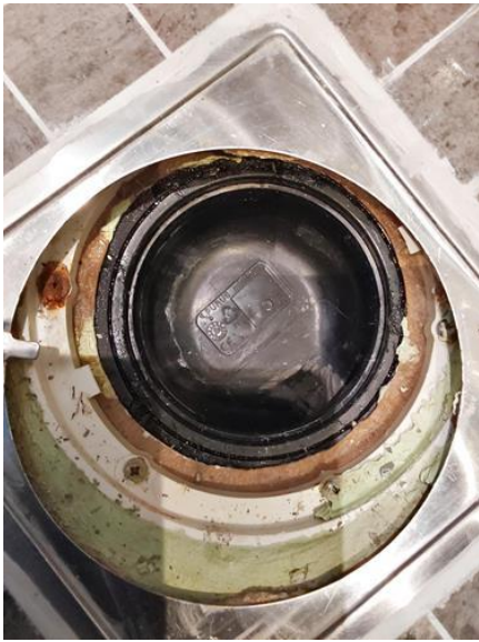
Våtrom - [Sluk på bad]
