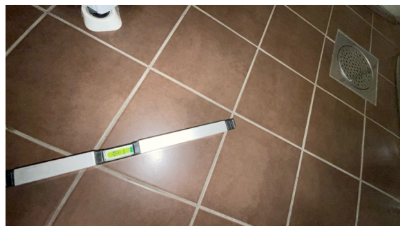
Fallforhold målt i retning sluk.
