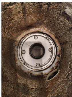
Tettesjiktets tilslutning til sluk - Sluk
