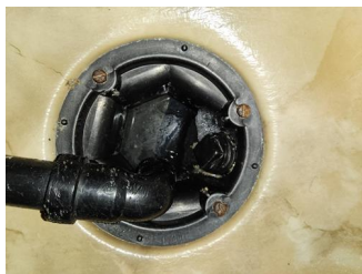
Tettesjiktets tilslutning til sluk - Sluk.
