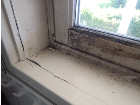
Vindu på bad 1. etasje
