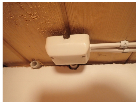
Løs koblingsboks i underetasje
