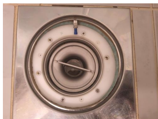
Tettesjiktets tilslutning til sluk - Sluk
