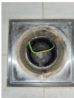
Tettesjiktets tilslutning til sluk - Sluk bad
