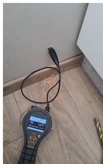
Utført kontroll i tilliggende konstruksjon - Fuktmåling
