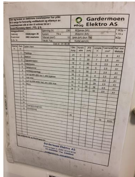
Elektrisk anlegg - [Kursfortegnelse]
