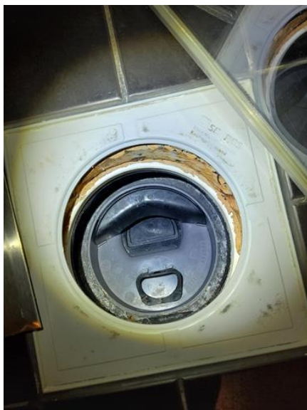
Membran, tettesjikt og overgang til sluk. - [Sluk bad med adkomst fra entré.]
