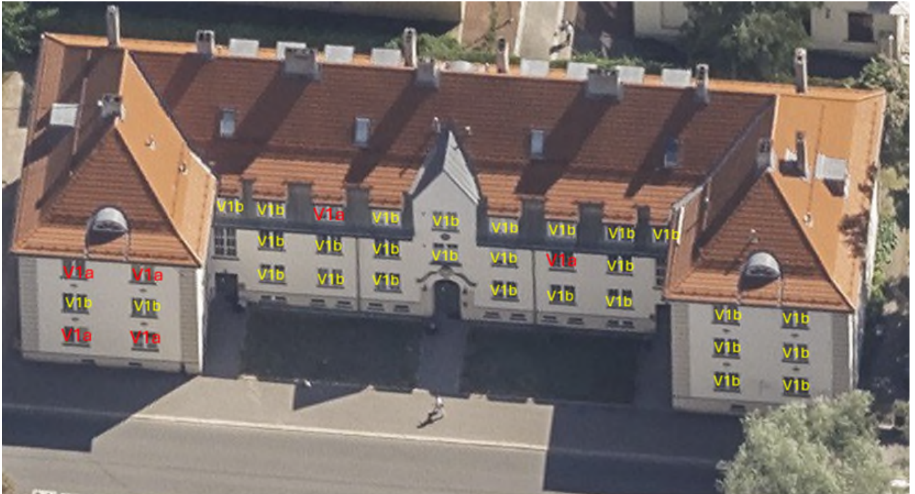
Bilde 12 – Viser fasade mot vest, hvor sidehengslsede vinduer fra 1981 er markert rødt.
