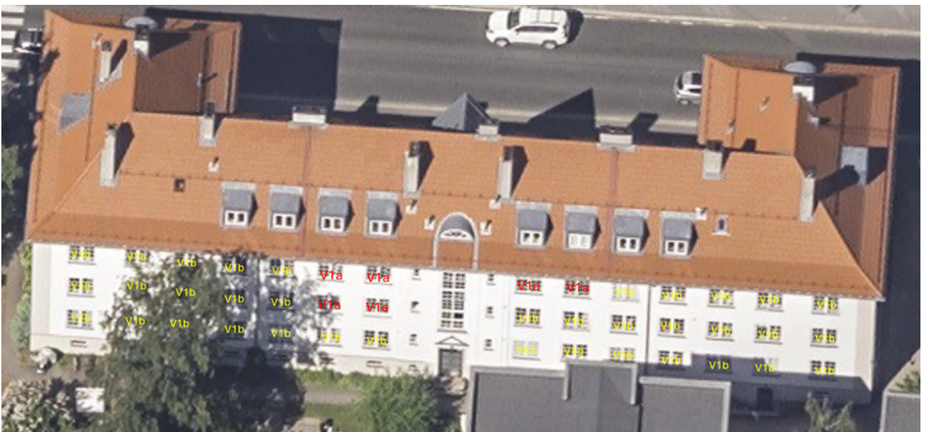
Bilde 12 – Viser fasade mot øst, hvor sidehengslsede vinduer fra 1981 er markert rødt.
