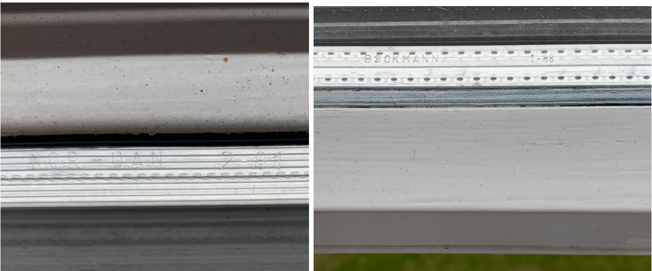
Bilde 7 og 8 – Viser produksjonsdato for sidehenglede (februar 1981) og toppsving vinduer (januar 1988)
