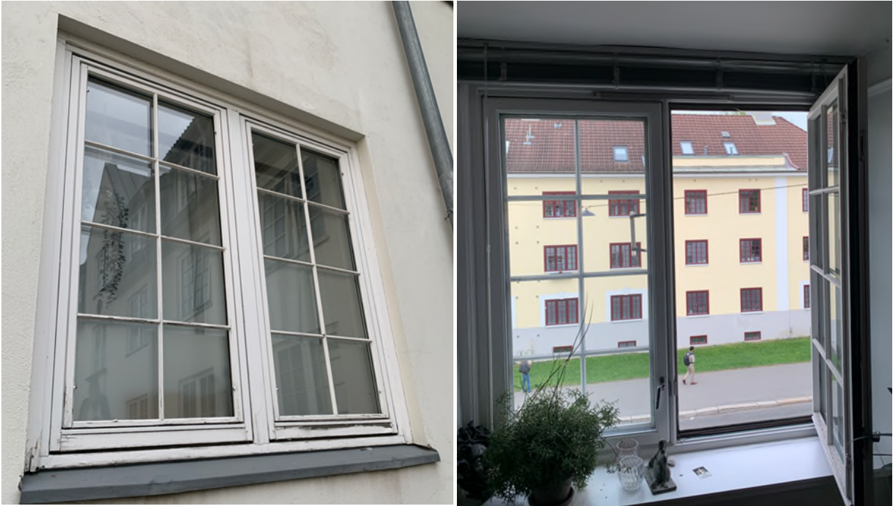
Bilde 2 og 3 – Viser sidehengslet vinduer fra utside og innside
