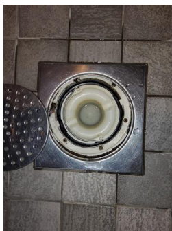
Tettesjiktets tilslutning til sluk - Sluk Baderom.
