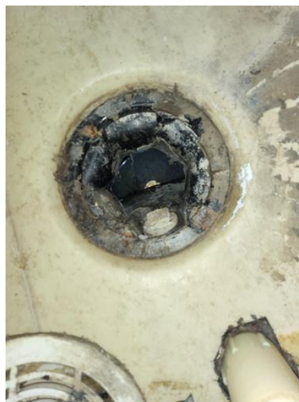
Membran, tettesjikt og overgang til sluk. - [Sluk bad med tilkomst fra kjøkken og sov]
