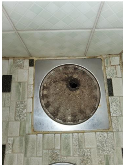
Membran, tettesjikt og overgang til sluk. - [Sluk/avløpsrør til vannavrenning dusj i bad med tilkomst fra entré]
