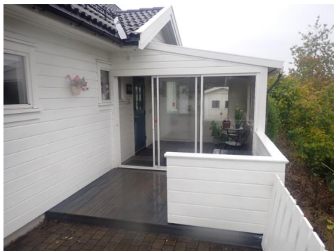
Vindfang ved inngangsparti.
