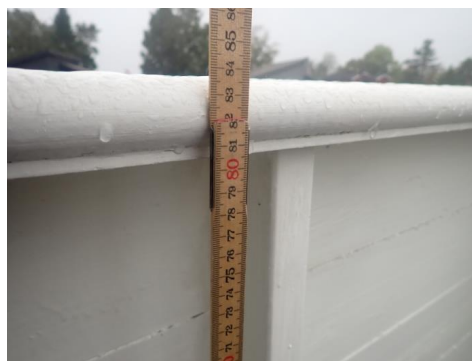
Rekkverk 84 cm høyt.
