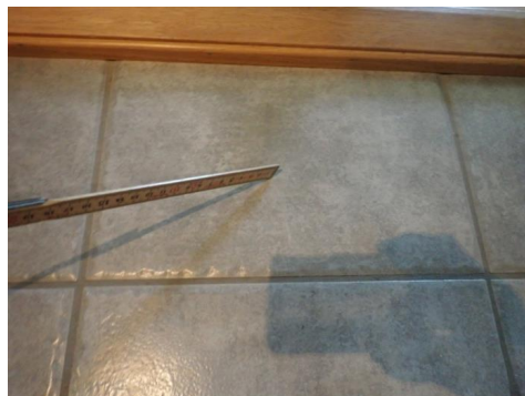
Det er "bom" på flere fliser.
