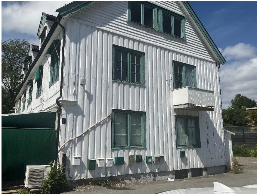
Endevegg på bygningen.
