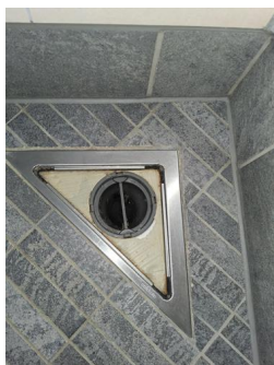
Tettesjiktets tilslutning til sluk - Sluk
