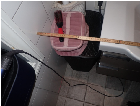
Vindu i våt sone mot vask
