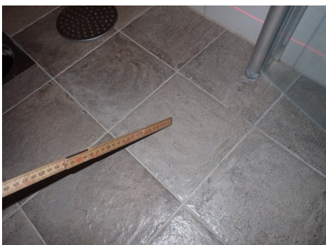
Hulromlyd under fliser flere steder
