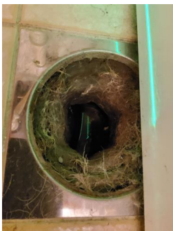
Tettesjiktets tilslutning til sluk - Sluk vaskerom.
