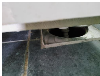
Tettesjiktets tilslutning til sluk - Sluk under dusjkabinett.
