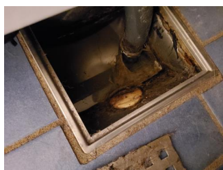
Tettesjiktets tilslutning til sluk - Sluk bad.
