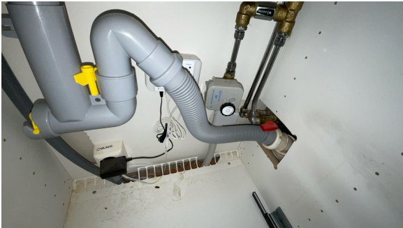
Vannrør på kjøkken. Lekkasjestopper.
