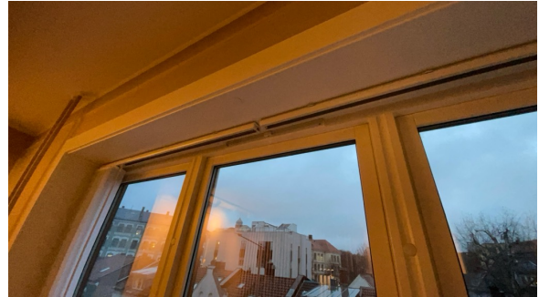
Luftespalte over vindu.
