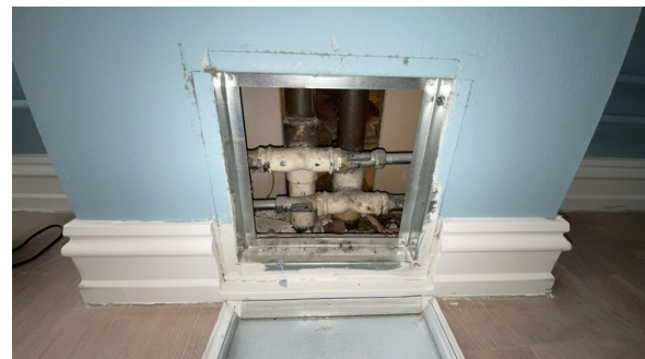
Originale radiatorrør innenfor inspeksjonsluker.
