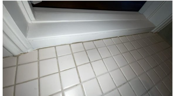
Overgang ved dørterskel.
