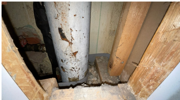
Avløpsrør på badetrommet.
