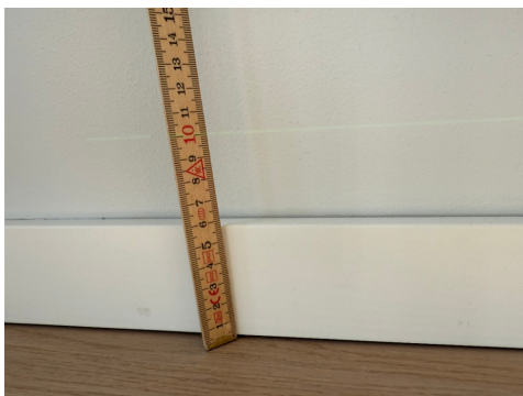
Måling ved balkongdør
