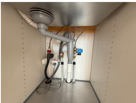
Rør i kjøkkenben
