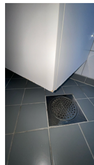
Slitasjemerker og svelling i servantskap.
