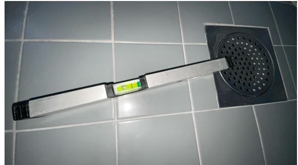
Fallforhold målt i retning sluk.
