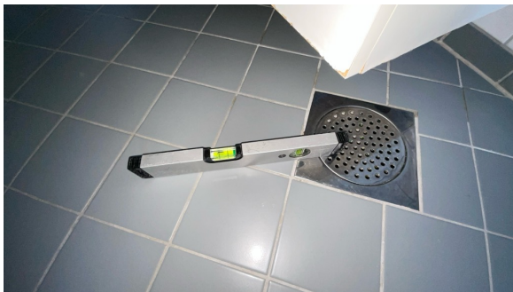
Fallforhold målt i retning sluk.
