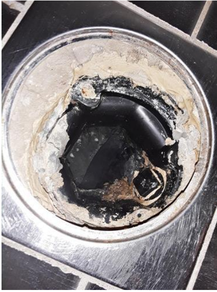
Våtrom - [Sluk bad]
