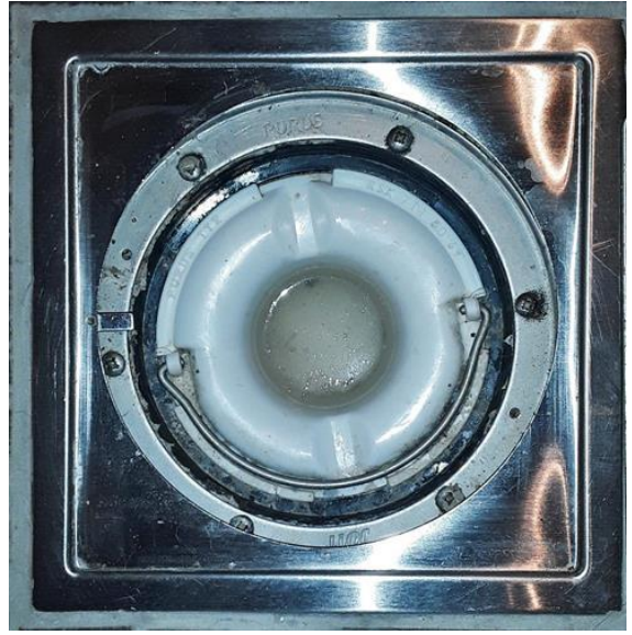
Våtrom - [Sluk vaskerom]
