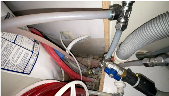
Røropplegg på baderom.
