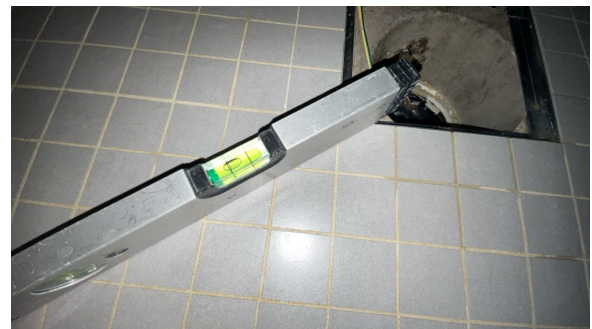
Fallforhold målt i retning sluk.
