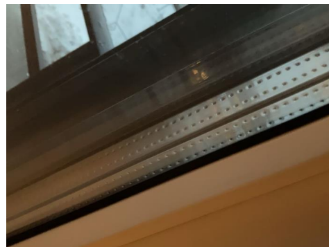
Balkong dør balkong kjøkkenside
