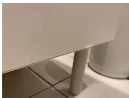
Fuktskadet skapvange
