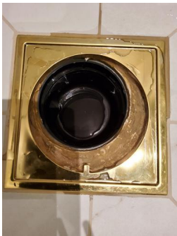
Tettesjiktets tilslutning til sluk - Sluk bad.
