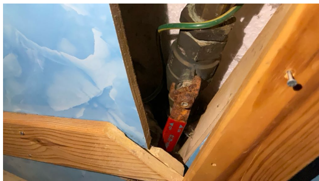
Hovedstoppekran i teknisk rom
