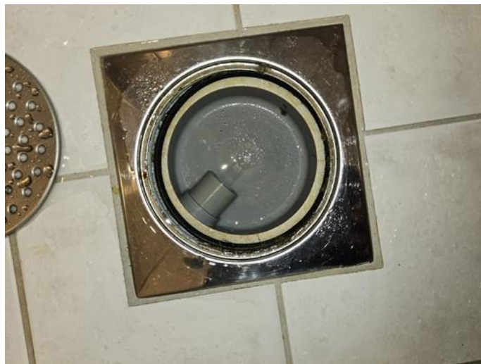
Membran, tettesjikt og overgang til sluk. - [Hjelpesluk, dusj.]
