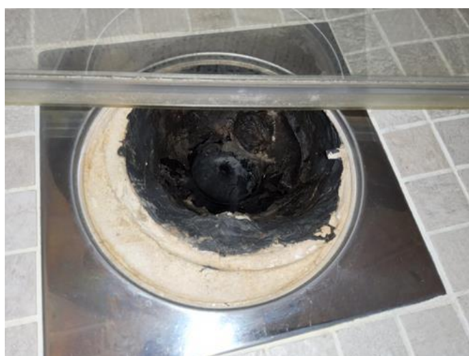
Membran, tettesjikt og overgang til sluk. - [Sluk bad 2. etasje. ]
