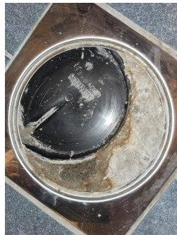
Tettesjiktets tilslutning til sluk - Hjelpesluk
