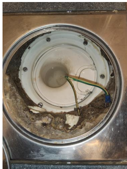
Tettesjiktets tilslutning til sluk - Hovedsluk
