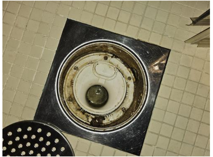
Membran, tettesjikt og overgang til sluk. - [Sluk, bad.]
