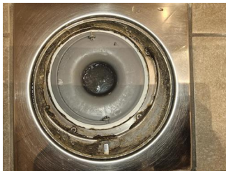
Tettesjiktets tilslutning til sluk - Sluk.
