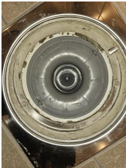
Tettesjiktets tilslutning til sluk - Sluk.
