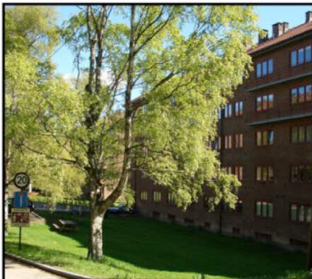
Fuktsikring Bjerketreallé plantet for å verne Maridalsveien 229 mot vanninntregning
