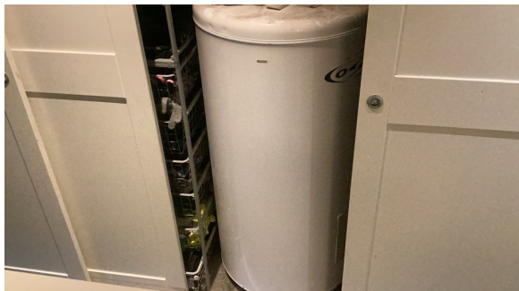
Varmtvannstank.
