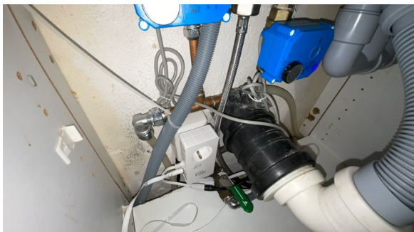
Røropplegg og lekkasjestopper på kjøkken.
