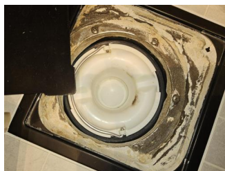
Tettesjiktets tilslutning til sluk - Sluk, bad.
